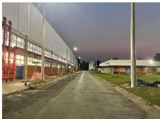
INSTALAÇÃO DA NOVA REDE DE POSTES
