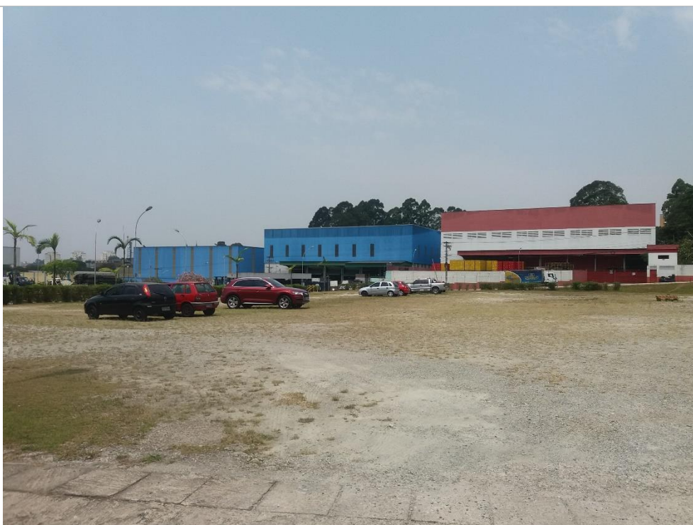
Vista interna do imóvel
