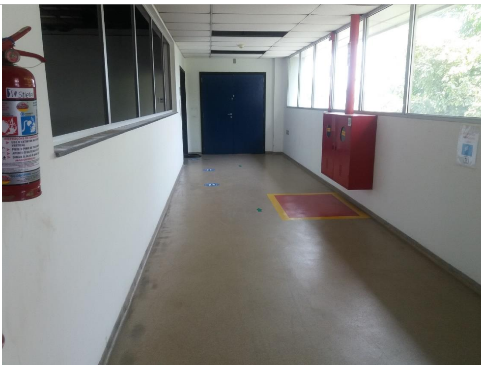
Vista interna do imóvel
