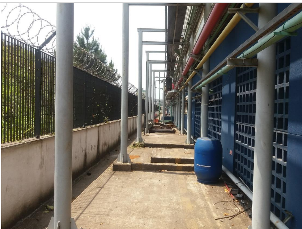
Vista interna do imóvel
