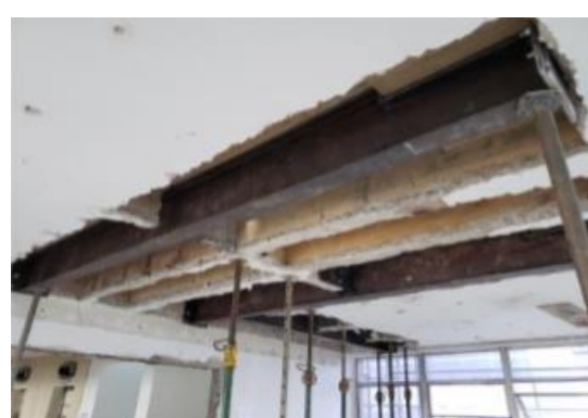
MONTAGEM – REFORÇOS METÁLICOS DOS SHAFTS
