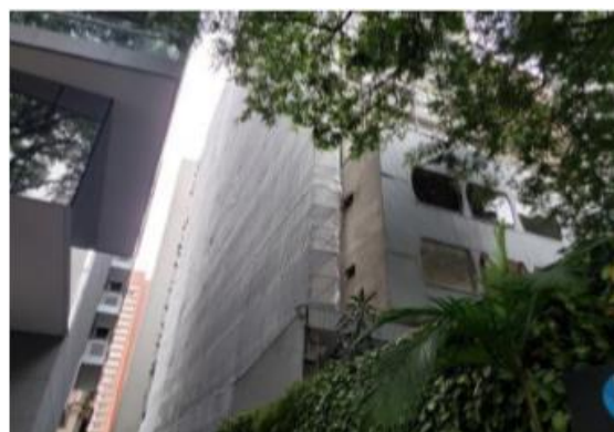
MONTAGEM DO ANDAIME FACHADEIRO (LATERAL ESQUERDA)
