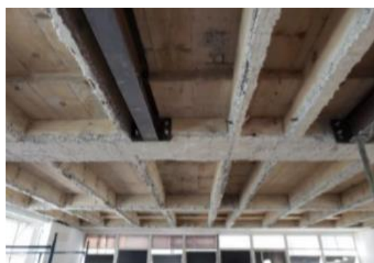
DEMOLIÇÃO - PARA REMOÇÃO DAS FORMAS DE MADEIRA
