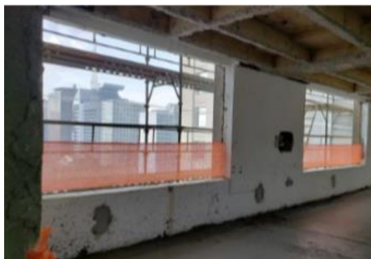
REMOÇÃO DOS VIDROS E CAIXILHOS EXISTENTES
