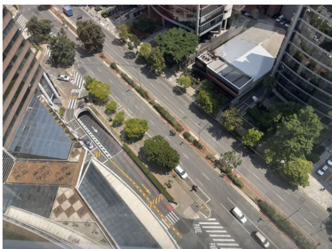
VISTA AÉREA DA VIA DE ACESSO
