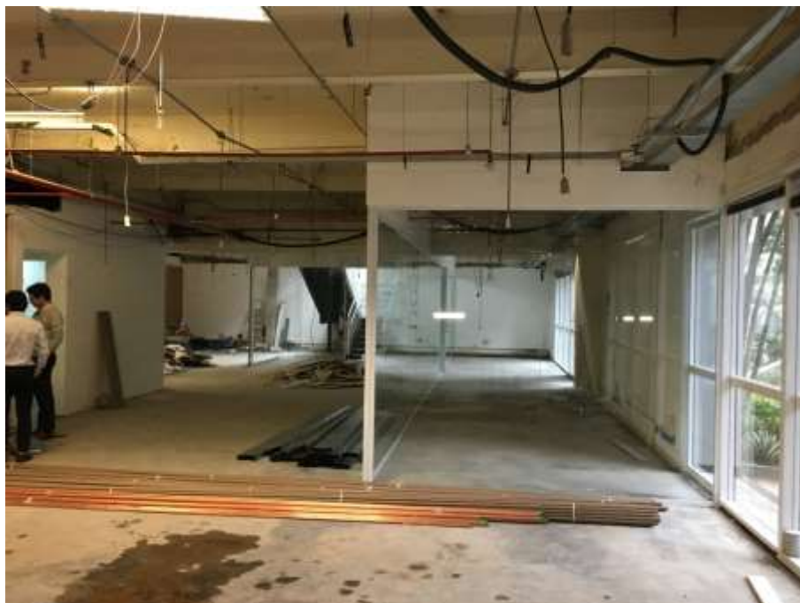
Vista interna do 1º subsolo
