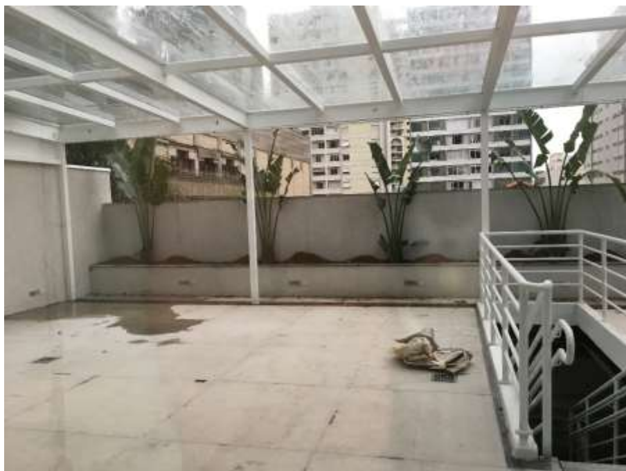
Vista interna da área expandida do térreo
