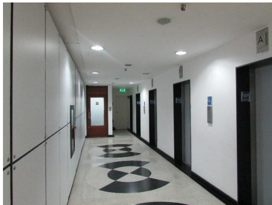
Substituição Ar Condicionado Áreas Privativas
