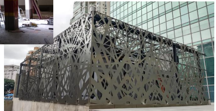
Sistema de Geração de Energia em Operação
