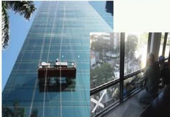
Manutenção da Fachada
