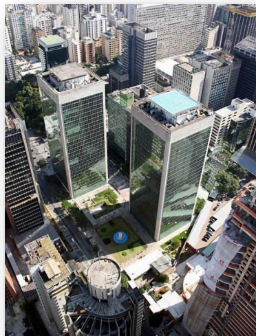
Cetenco Plaza (2 andares)
