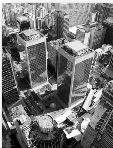
Cetenco Plaza (2 andares)
