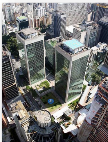
Cetenco Plaza (2 andares)
