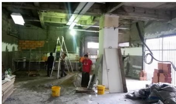
31/10/2013 Reboco de paredes
