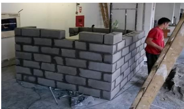
01/11/2013 Paredes do cofre
