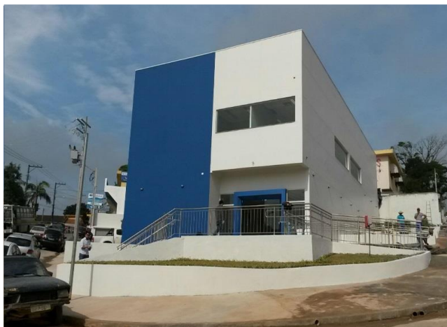
Imóvel - Cipó Guaçu (100% Concluído)
