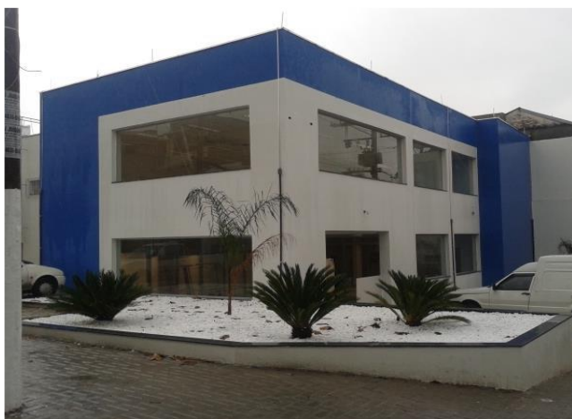
Imóvel - Rua dos Italianos (95% Concluído)
