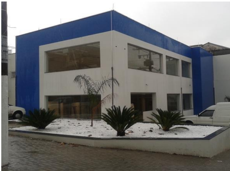
Imóvel - Rua dos Italianos (XX% Concluído)
