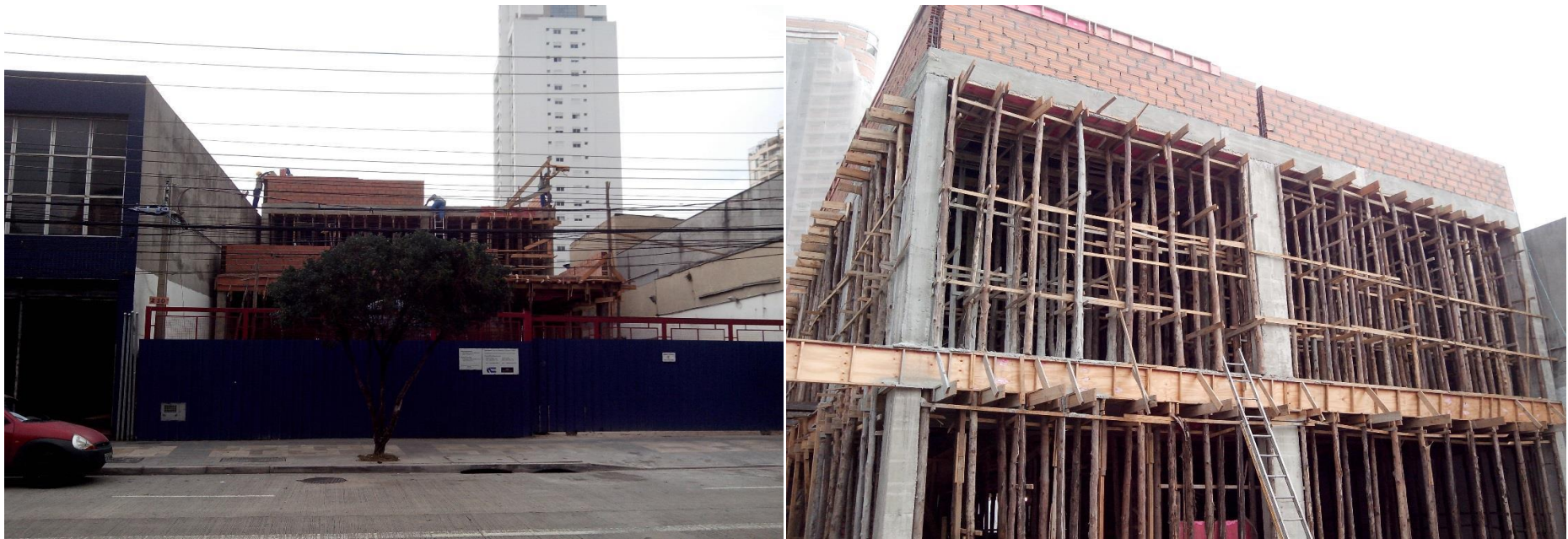
Imóvel - Paes Leme (34% Concluído)
