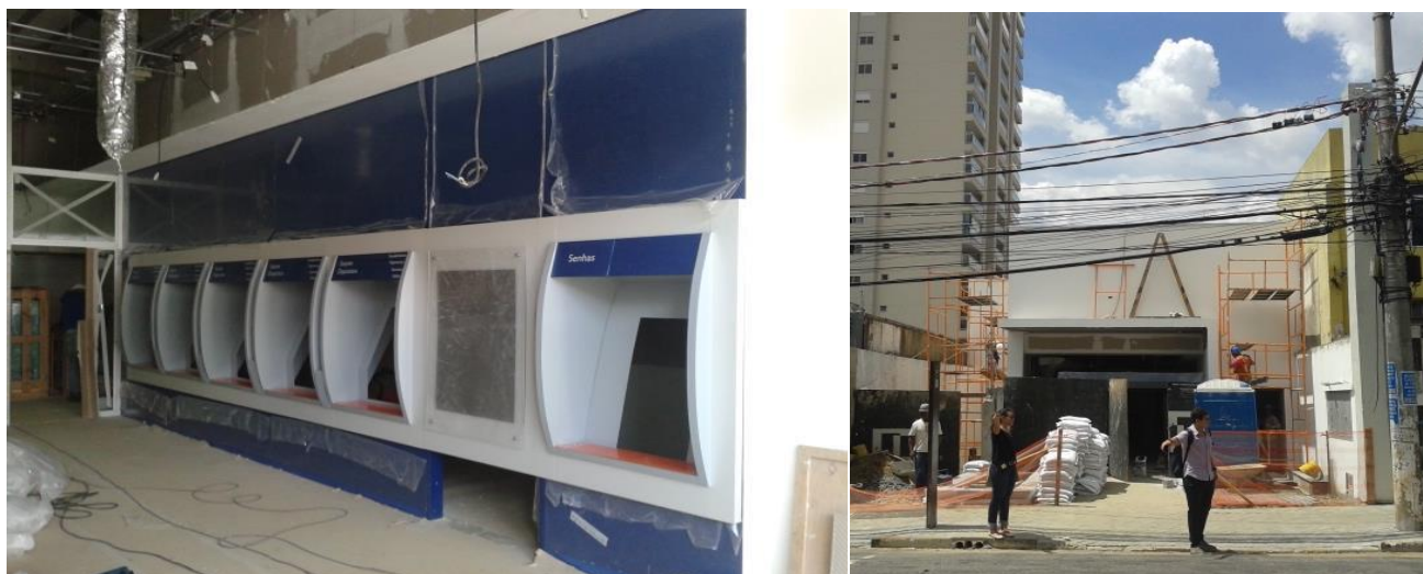
Imóvel - Vila Mascote (88% concluído)
