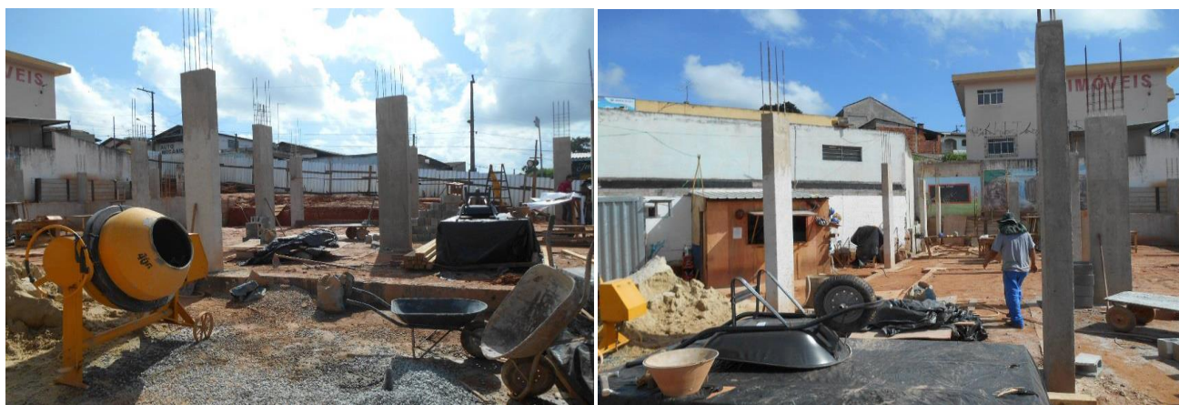
Imóvel - Cipó Guaçu (16% concluído)
