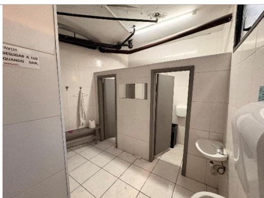
Banheiro dos funcionários
