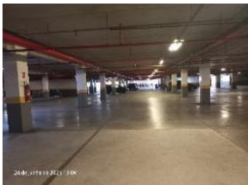
Estacionamento no subsolo
